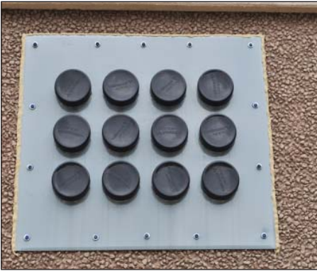
Waveguide/Feed-Thru Plate
