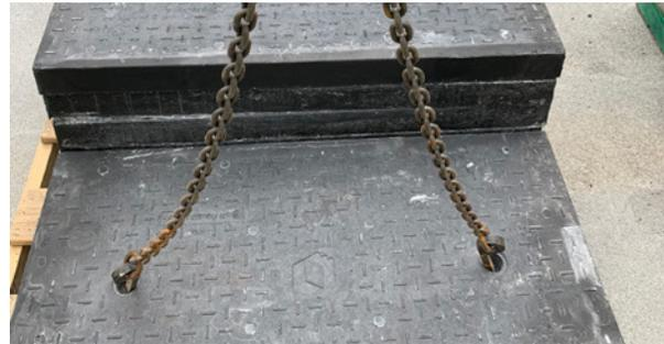
Soulèvement du couvercle avec des chaînes et un chariot élévateur
