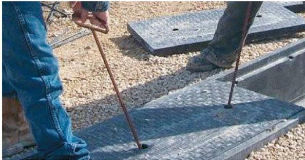
Soulèvement du couvercle pour deux personnes avec crochets de levage
