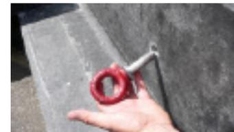
3. Insérez le boulon à œillet avec l'œillet vers l'intérieur du canal
