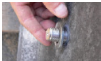
4. Inserte la segunda arandela plana
