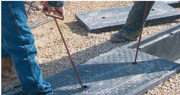
Elevación de cubierta realizada por dos personas con ganchos de elevación
